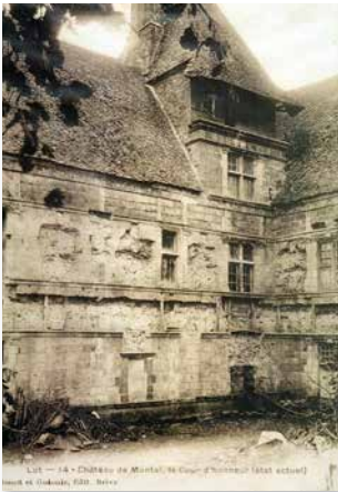
Château de Montal avant restauration, 1908
